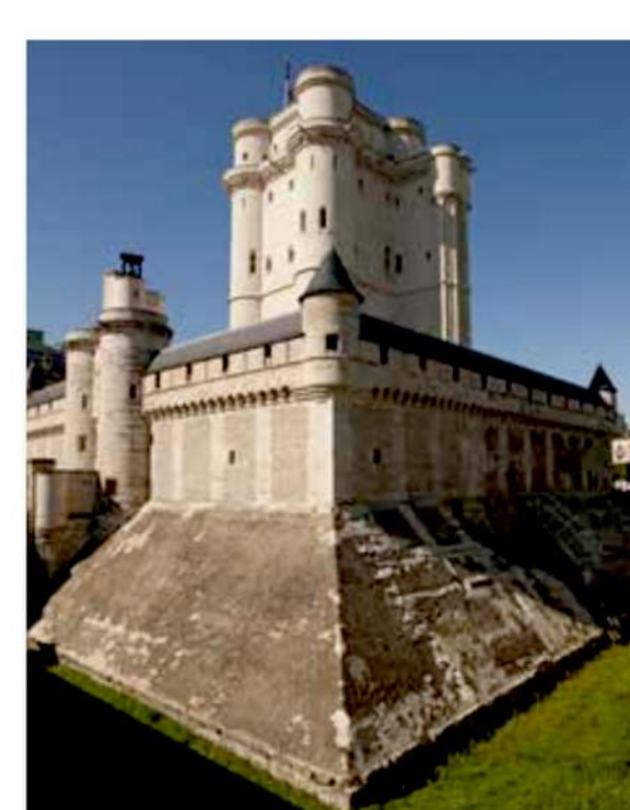
Donjon, enceinte et fossé nord
